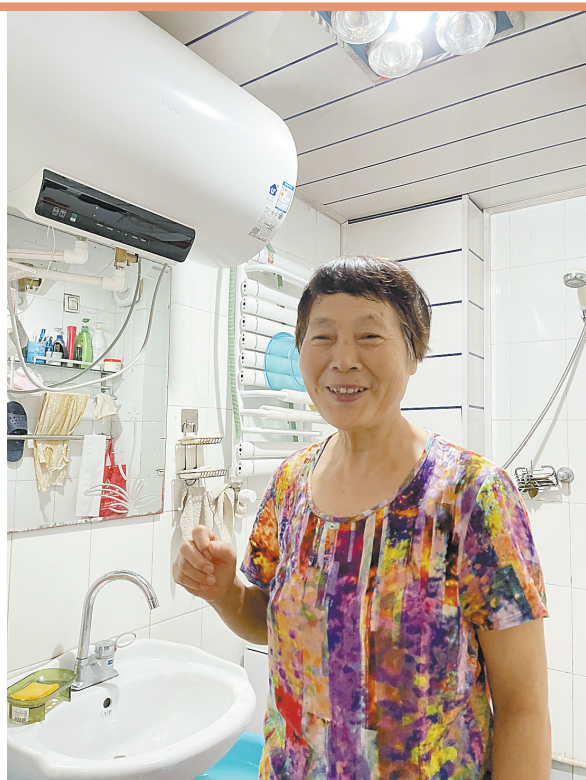
新华区残联免费为王许仙家安装了热水器和无障碍设施
