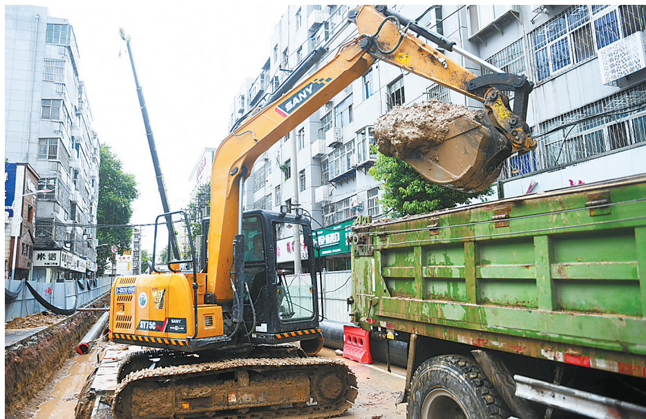
中兴路与曙光街交叉口附近,大型挖掘机正在施工
