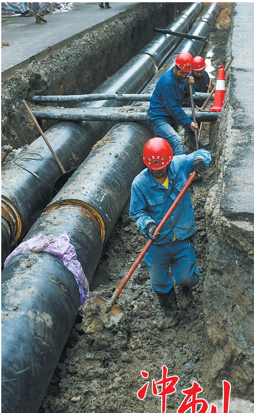
8月31日上午,市区曙光街西段“汽改水”改造工程现场,施工人员为刚刚铺好的管道垫土。 本报记者 禹舸 摄
