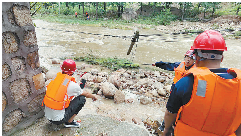
8月22日,平顶山联通公司防汛抢险队员在鲁山县瀼河乡东沟抢修受损线路 (图片由平顶山联通公司提供)
