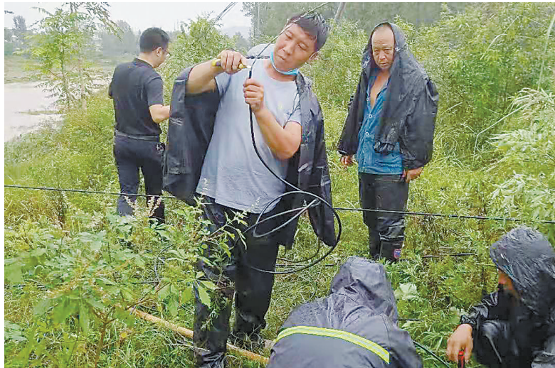
平顶山移动公司网络抢修队在瀼河乡土门村紧急抢修骨干线路 (图片由平顶山移动公司提供)
