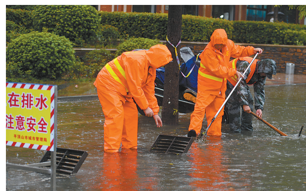
城管队员在清理雨水窨井口处的堵塞物。本报记者 禹舸 摄
