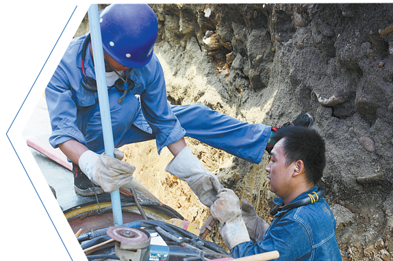
▲电焊工在修正、打磨焊点
