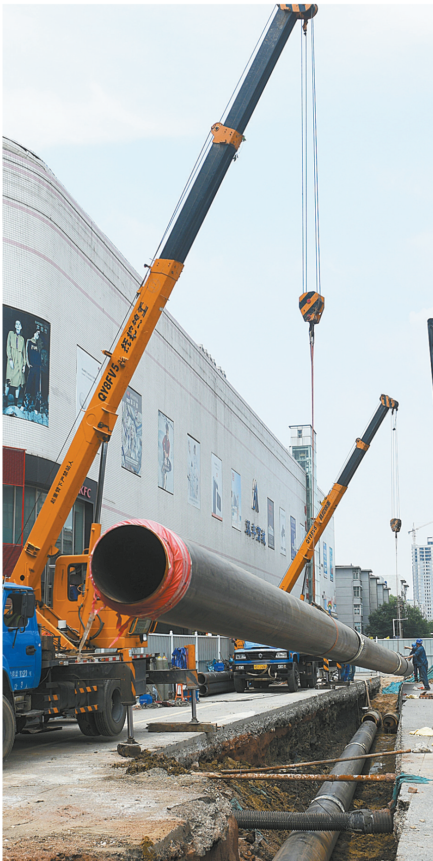
▲市区曙光街与光明路交叉口,工人在吊装500毫米供热主管道
