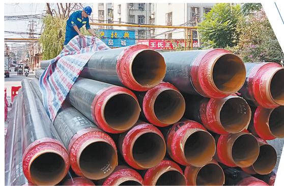
▲市区荟文街上,工人在搭盖管道
