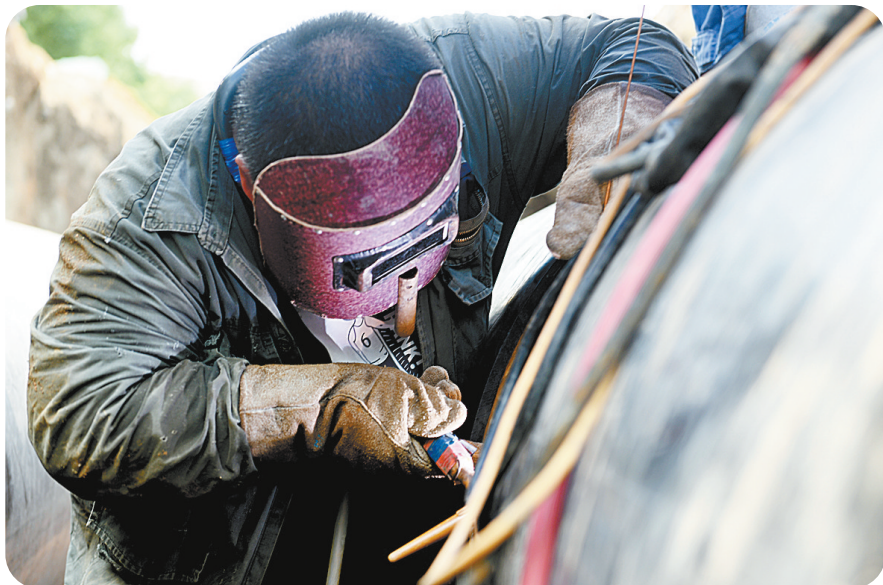
▲电焊工在焊接管道
