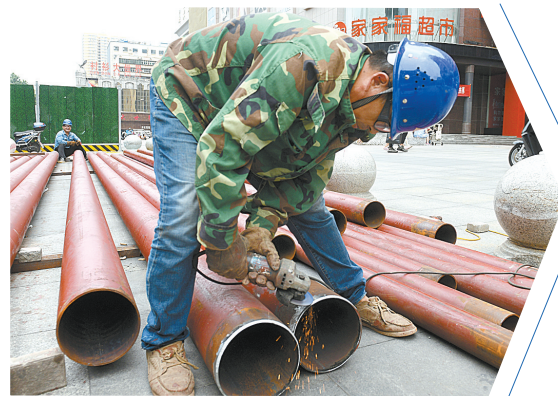
▲开源路施工现场,工人在打磨外架管道,以方便后续焊接
