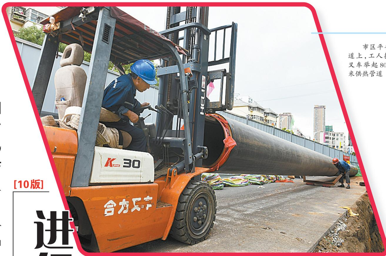
市区平安大道上,工人操作叉车举起800毫米供热管道
