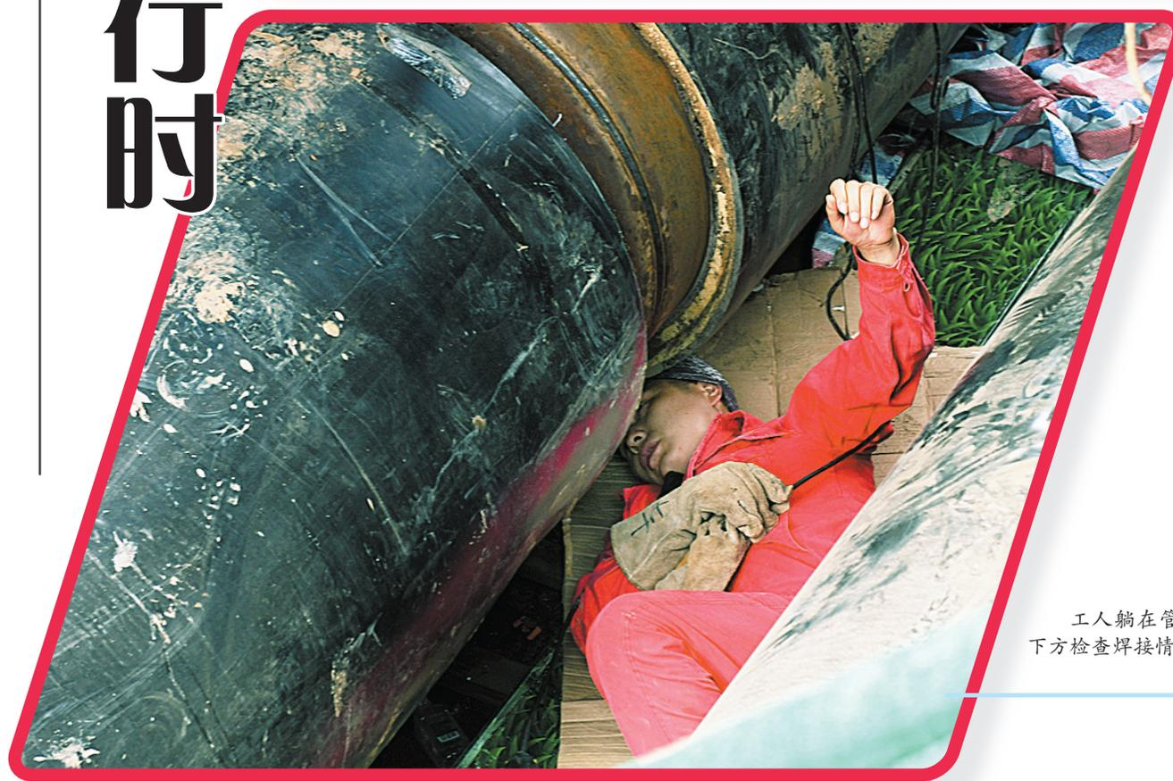
工人躺在管道下方检查焊接情况
