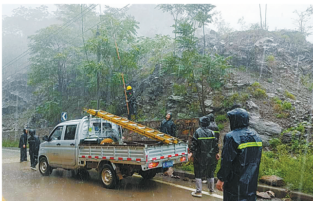
平顶山联通公司工作人员冒雨紧急布放通往汝州市大峪镇的光缆
