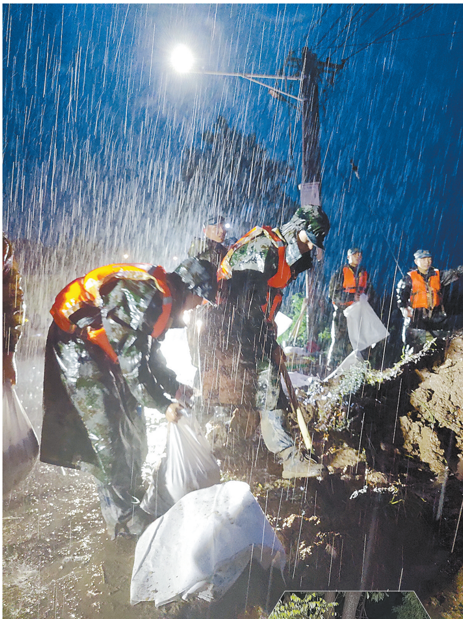
7月21日,驻扎在开封的空降兵某旅官兵冒雨在贾鲁河祥符区段加固堤坝。
