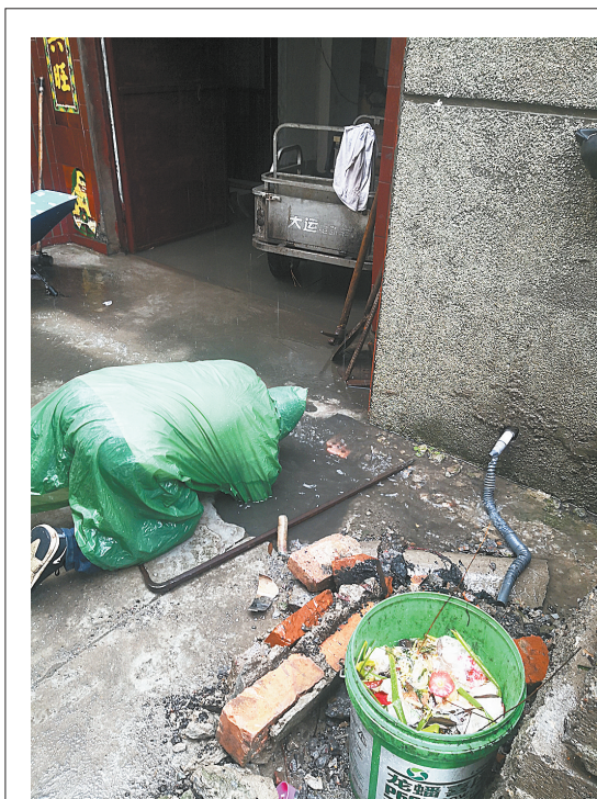
工作人员下手疏通谢庄村村民家门口的下水道
