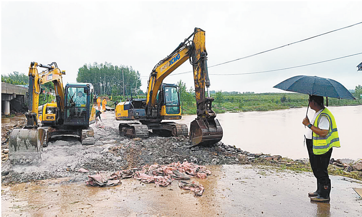
抢修人员在鲁山县马楼乡肥河桥抢修道路
