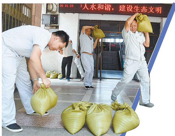
7月14日,市自来水公司大门前,防汛人员肩扛沙袋迅速封堵厂区入口,避免雨水倒灌淹没办公区。
