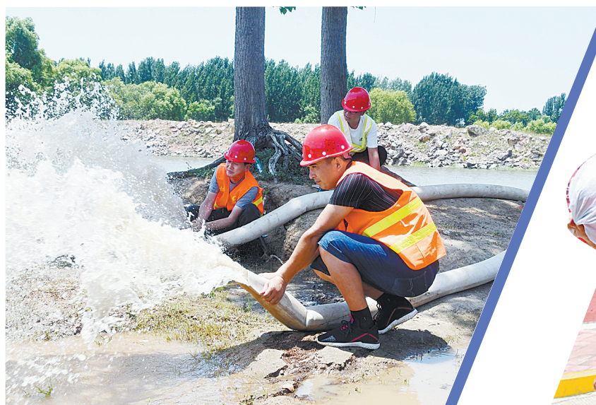
7月13日,市政维修二队在沙河开展了“城市内涝防汛”演练。模拟城市道路被暴雨淹没后,抢险车辆迅速到达现场开展道路排水。
