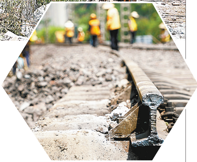
▲工作人员在太焦铁路东坡到孔庄间线路上整修轨道
