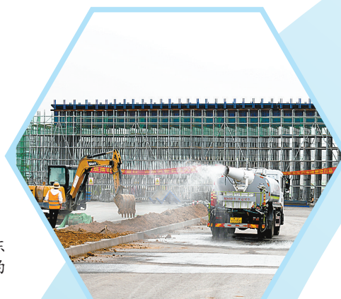
► 鹰城大道东段正在施工的人行天桥
