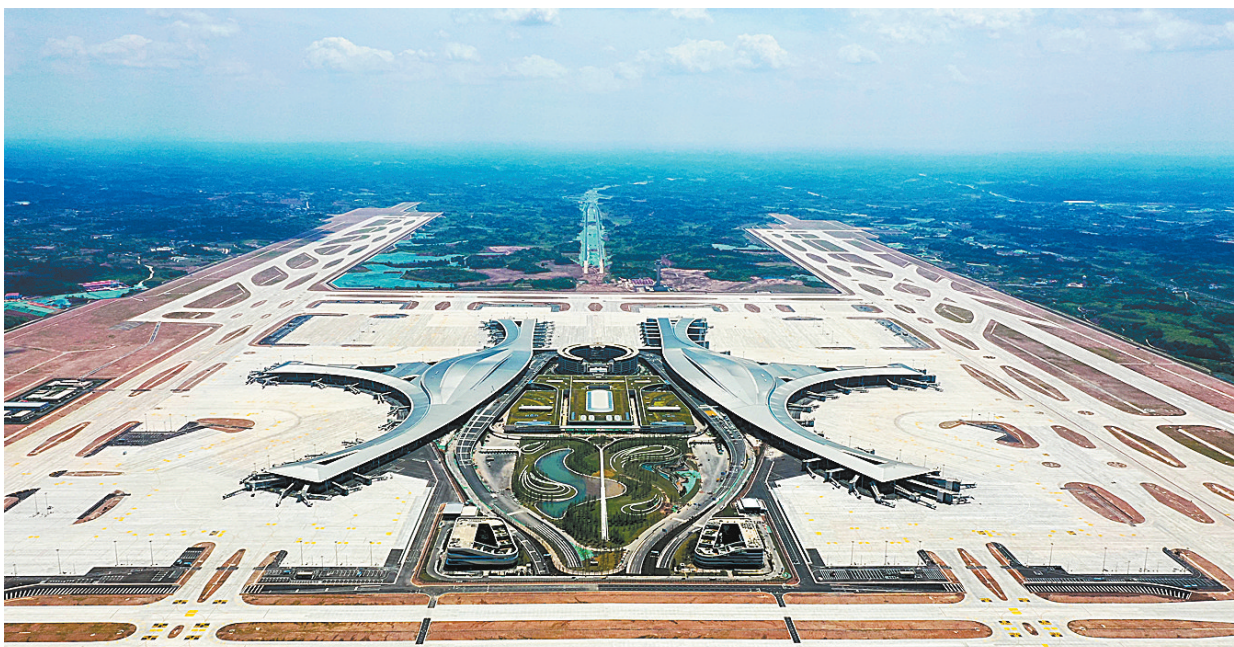
这是5月11日航拍的成都天府国际机场(无人机照片)。
