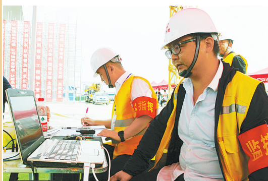
转体指挥台上,总指挥和总监控员查看着主梁的转体速度,记录转体数据,实时发出指挥调令
