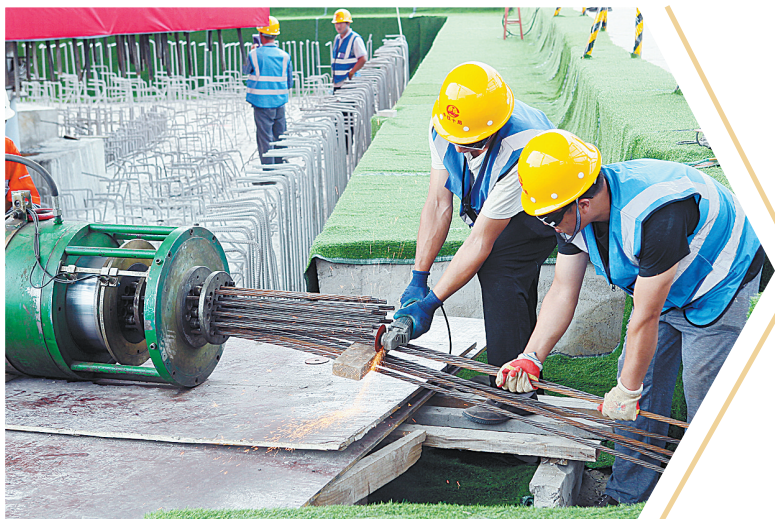
施工人员将液压机拉出的转体牵引钢绞线截断
