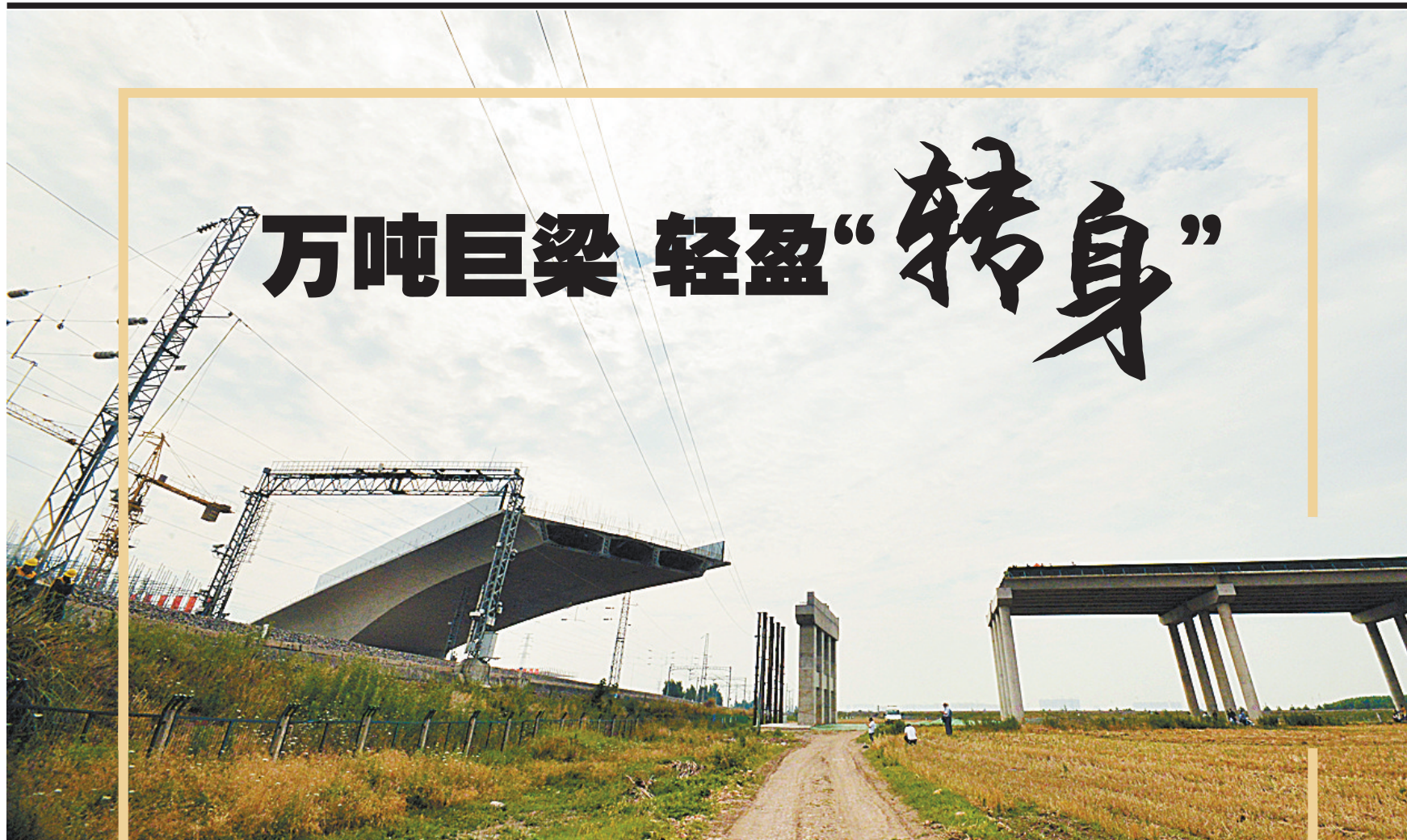
重约1.38万吨、全长140米的主梁在孟宝铁路上方轻盈“转身”
