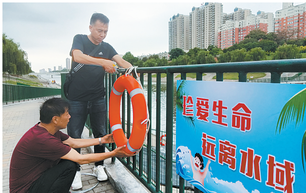
淇河工程运行保障中心工作人员正在沙滩浴场橡胶坝岸边安装救生圈。
