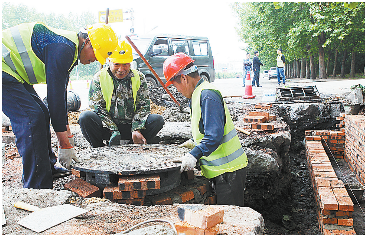
5月17日,在市区建设路与昆阳大道立交桥西侧,市政维修二队的工人在为新增设的雨水窨井安装井盖。
