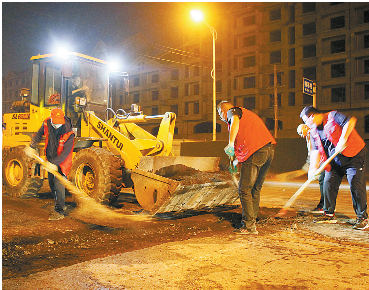
5月12日晚,在卫东区东环路街道魏寨村南的平安大道上,市城管局市政维修队职工在铣刨机、装载机等大型施工机械配合下,对路面进行维修施工。 本报记者 李英平 摄
