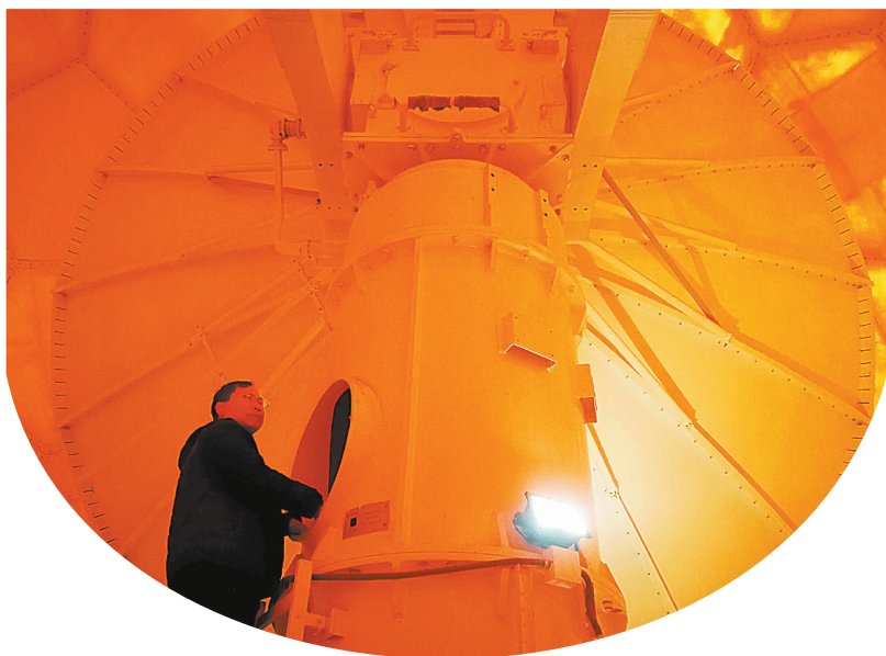
▼观测员在雷达顶端机房维护雷达天线。
