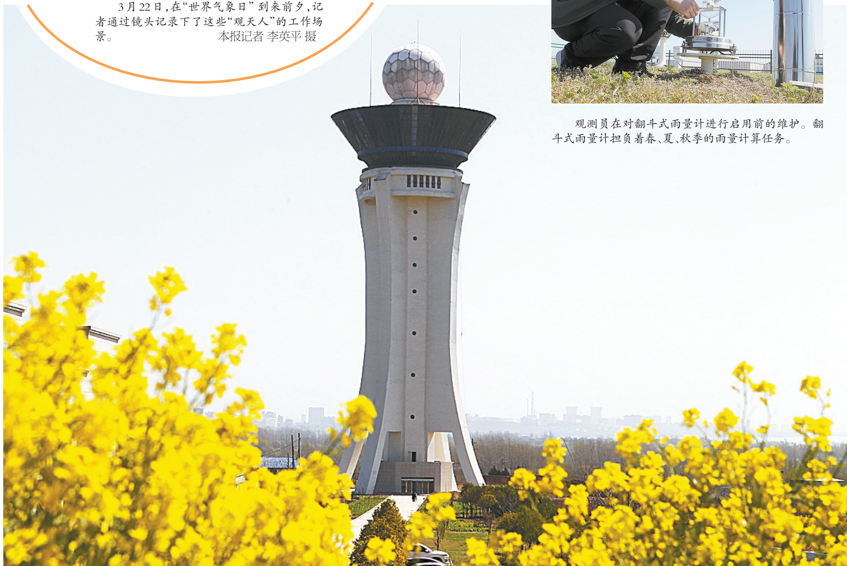
安装在高达71.4米塔座上的新一代多普勒天气雷达,能准确观测到半径为230公里范围内高空云团的运动轨迹、云内含水量等变化数据。
