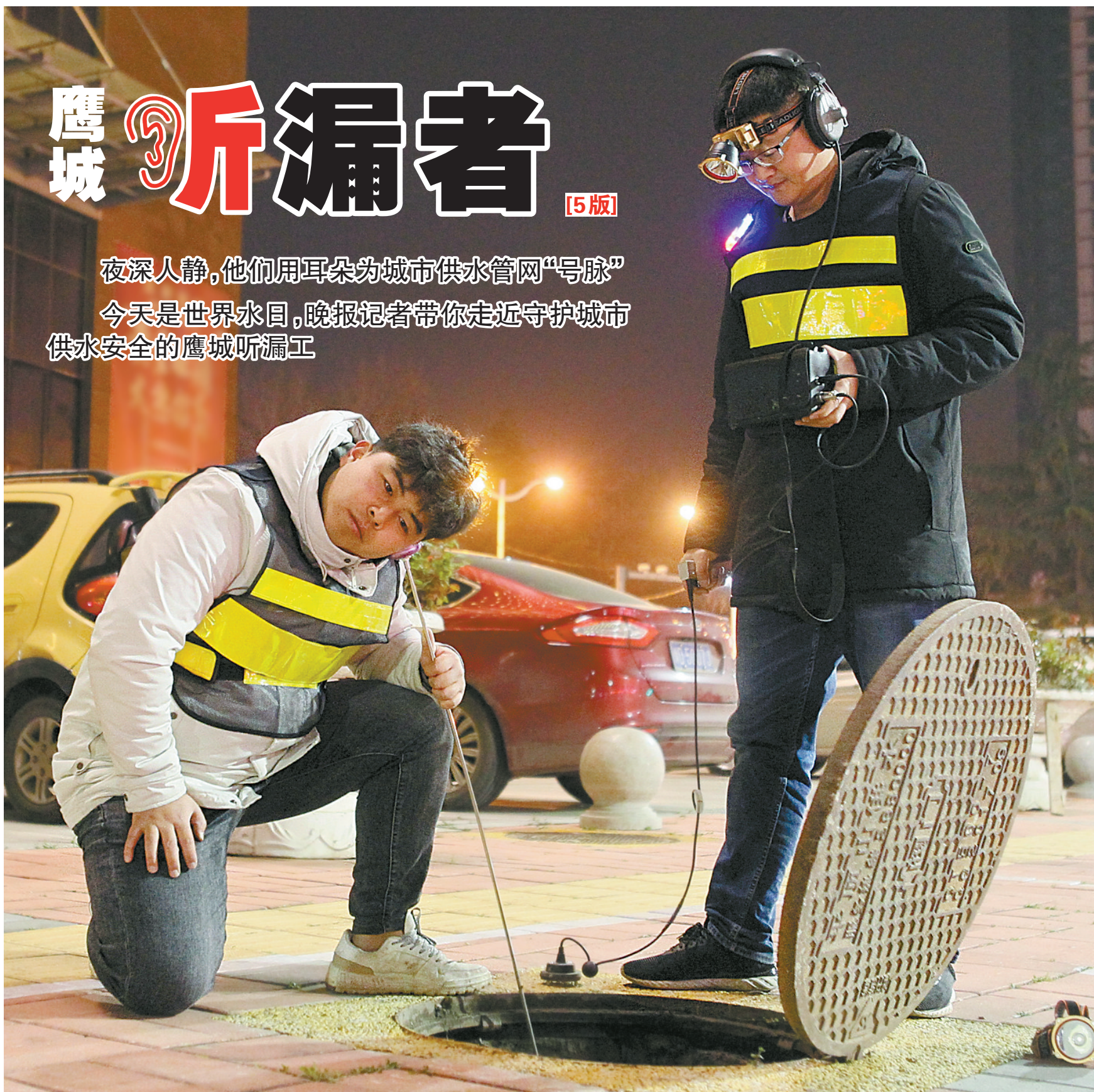
听音杆和听漏仪共同上阵,测漏工准确定位漏点。 本报记者 李英平 摄
