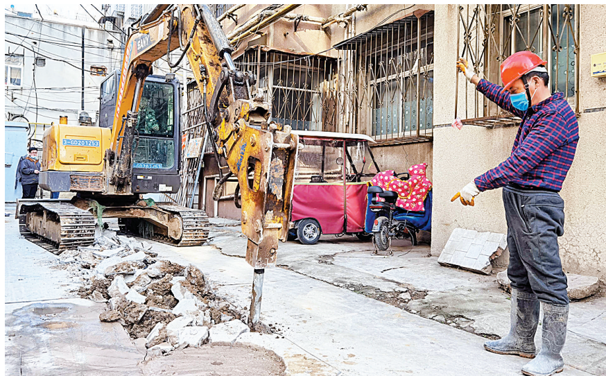
▼光明路189号院,工程人员指挥机器施工
