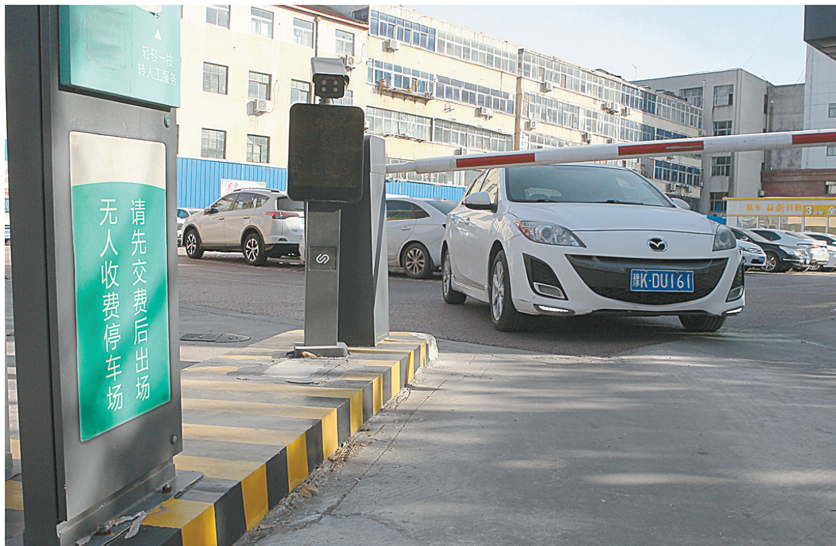
在鹰城广场东侧的停车场，安装在入口的智能识别系统对进出车辆进行自动识别后抬杆放行，车辆无需停顿，顺利进入车位。
