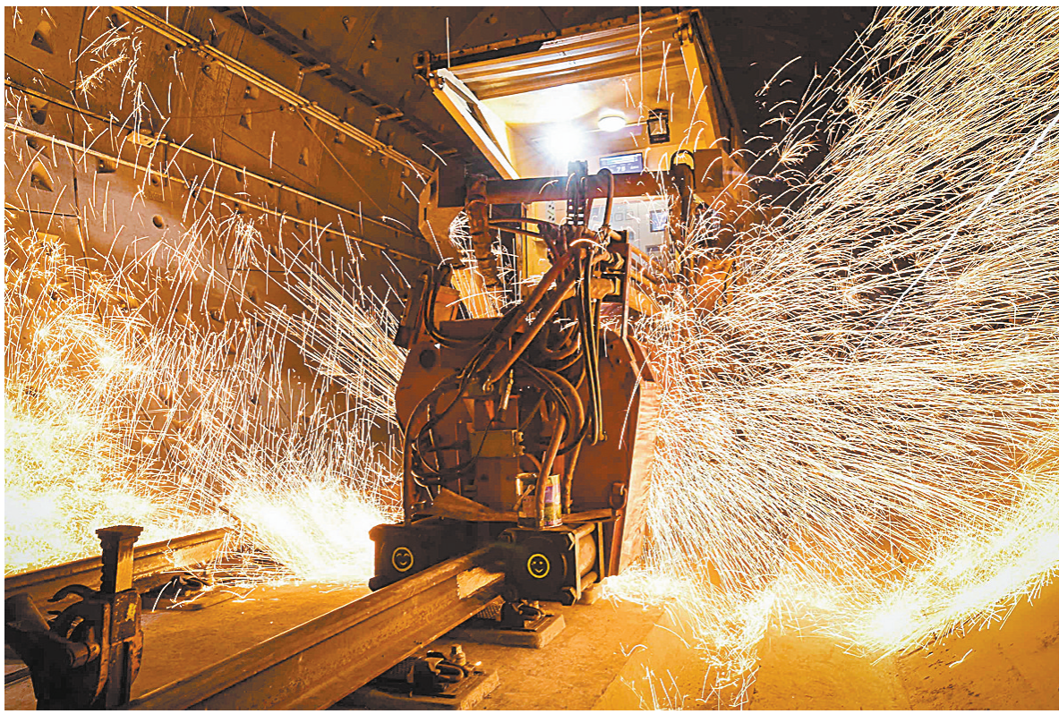
焊花“绽放”广州地铁18号线
