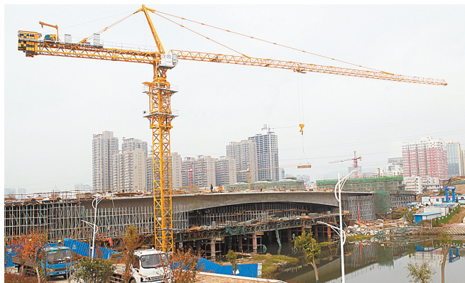
2018年11月,东环路漯河桥主体完工
