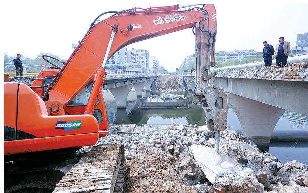
2010年4月,施工人员对开源路漯河桥中间桥体进行拆除重建
