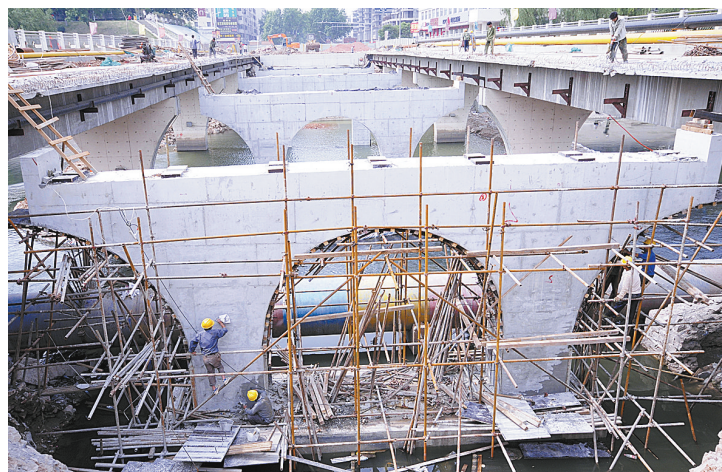
2011年5月，光明路漯河桥重建，桥墩浇筑完毕。
