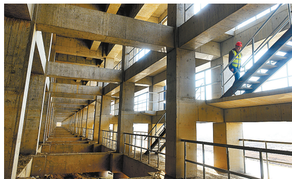
平顶山港散货码头下钢筋混凝土支柱林立
