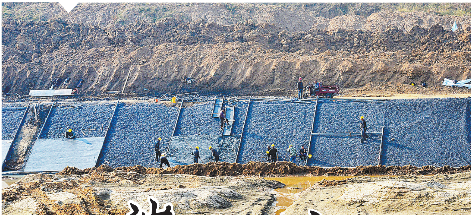
平顶山港沙河航道护坡施工现场
