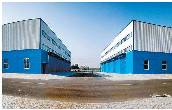
叶县港区建成的大型物流仓库
