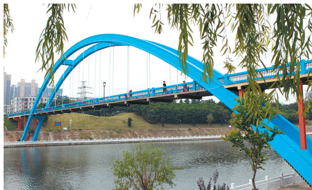
2018年8月底,维修施工结束,众福桥以崭新的面貌呈现在市民眼前
