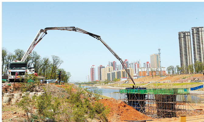
2018年4月,施工人员在浇筑稻香路湛河桥桥墩。
