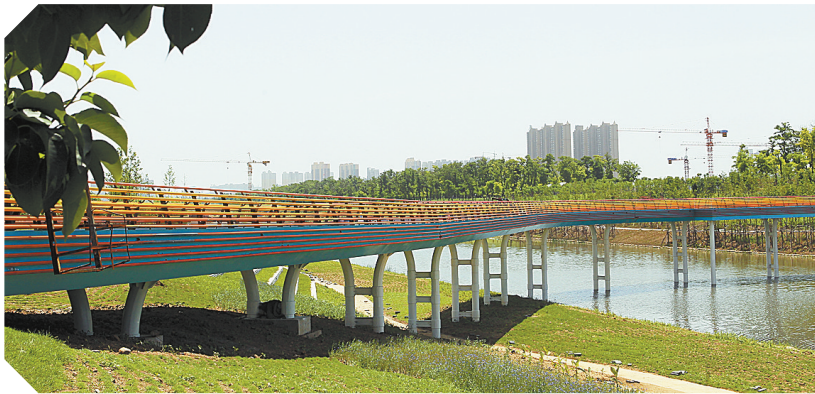
2018年7月，主体完工的景观桥进入封闭养护期
