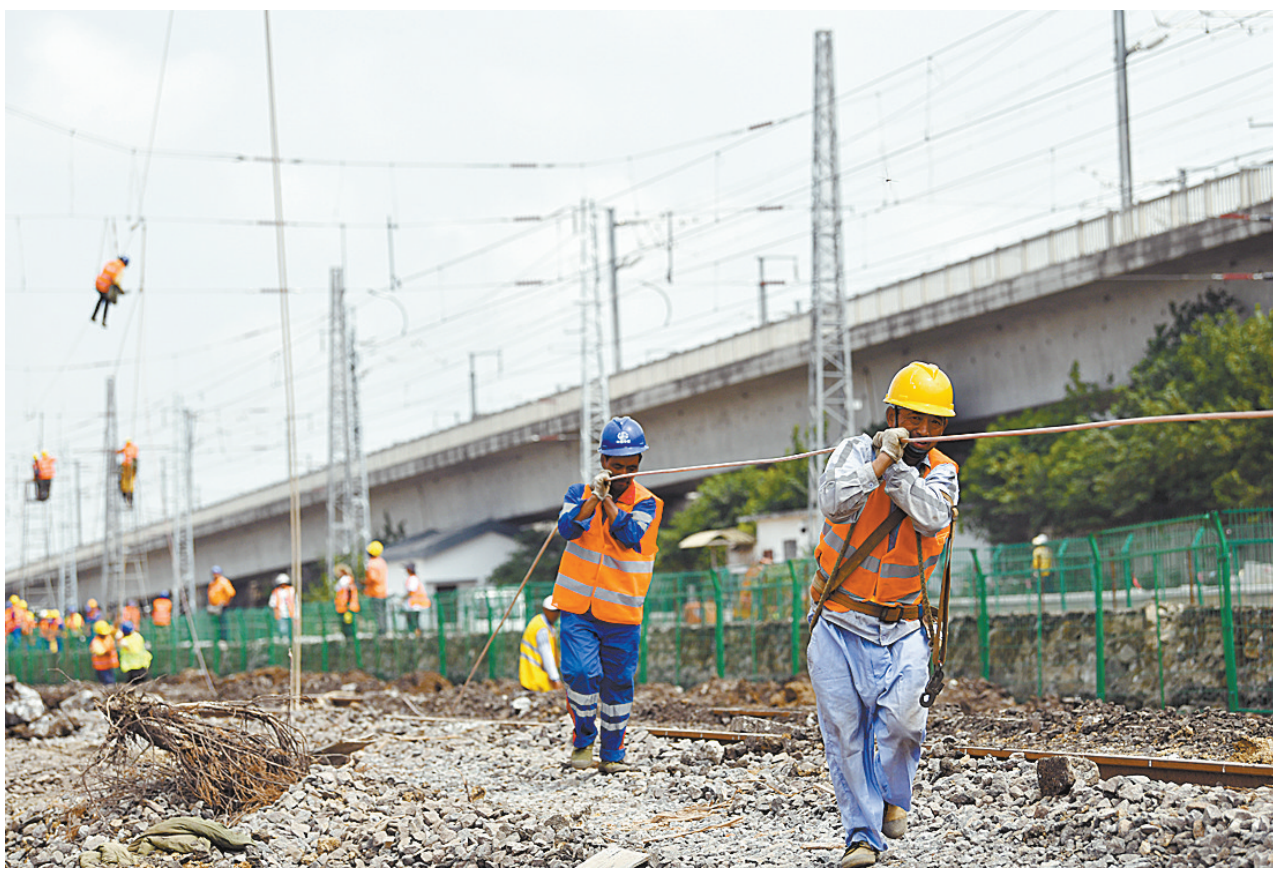
铁路建设施工忙
