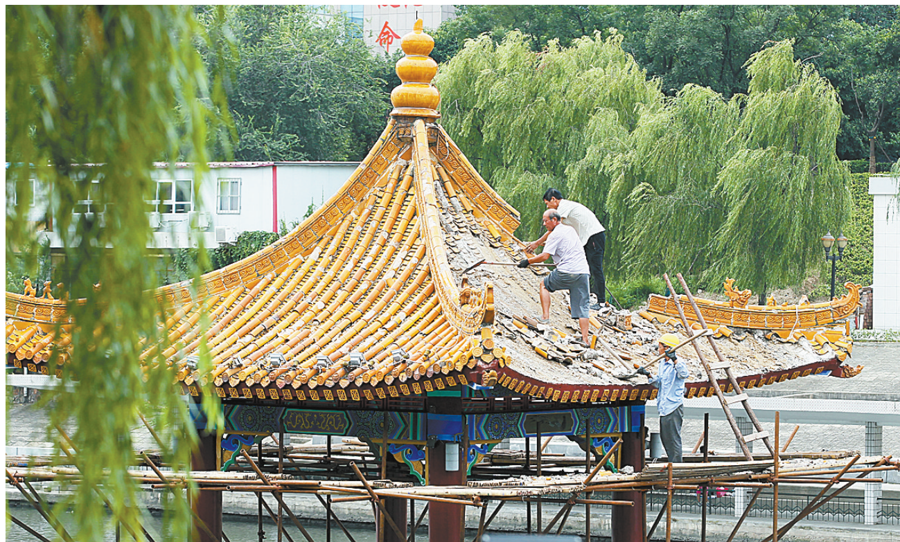
昨天,施工人员在拆除九曲亭破损的琉璃瓦。从当天起,位于市区中兴路湛河桥西侧河道中的九曲亭开始全面大修。此次大修包括屋顶琉璃瓦重新铺设、桥栏粉刷、地面修整、照明灯具维护等内容,达到与提档升级后的湛河公园景观相协调。预计国庆节前九曲亭将以整洁悦目的面貌呈现在市民面前。 本报记者 李英平 摄
