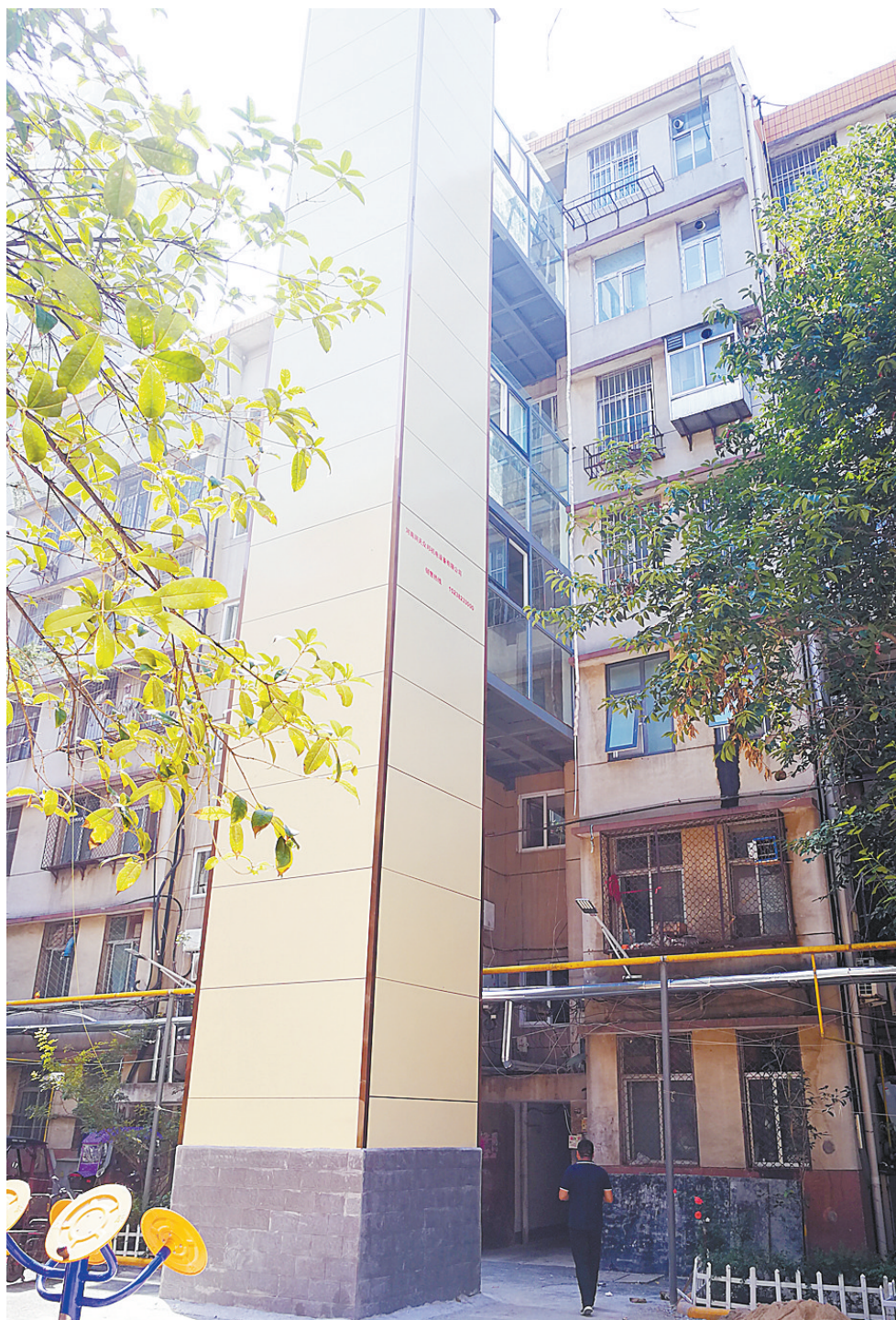
民主街5号院9号楼2单元刚刚安装好的电梯
