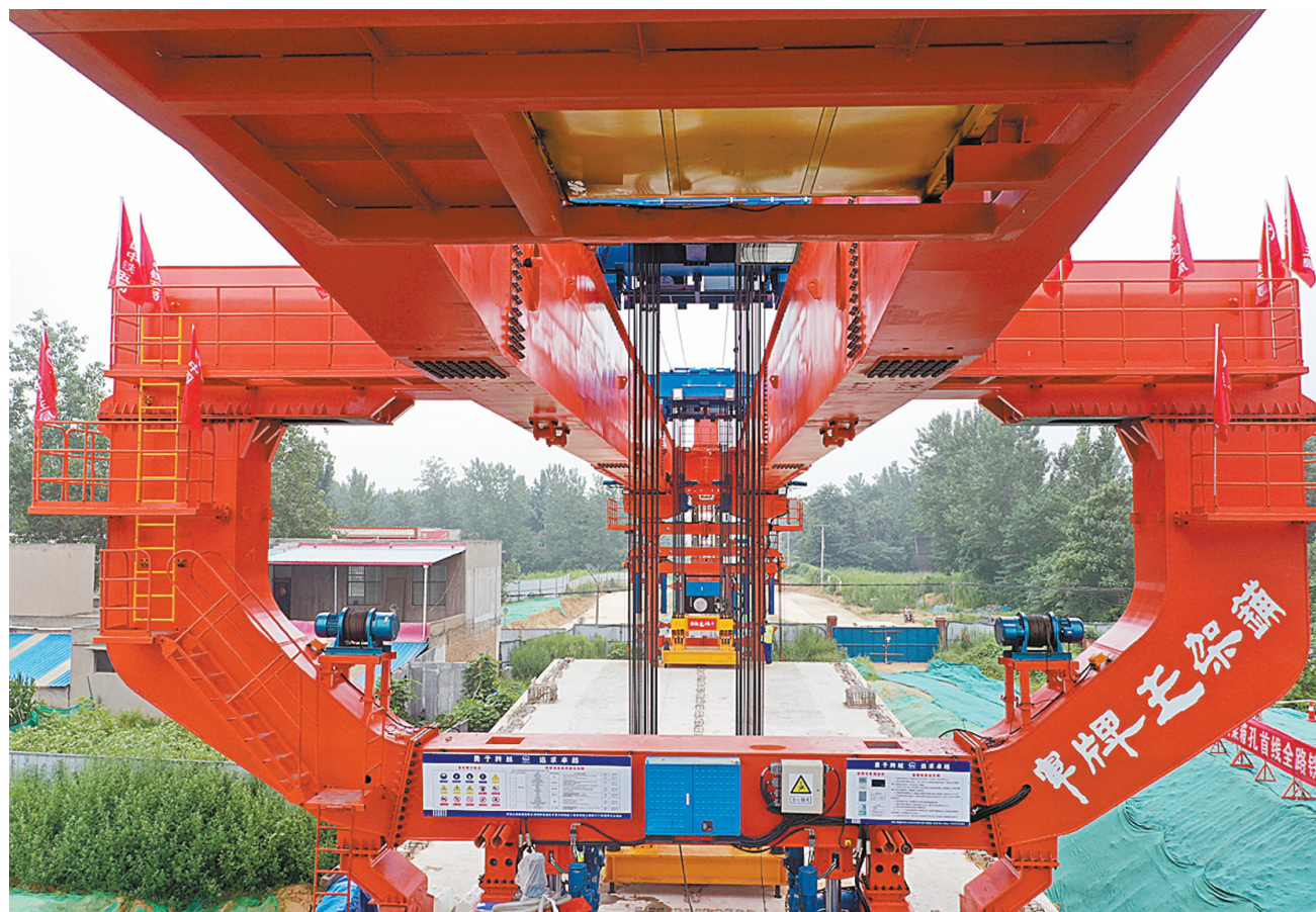
郑许铁路全线架设首孔箱梁
