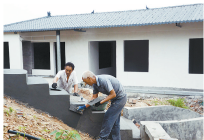
闫口村幸福大院正在建设中,建成后将为村里老人提供服务
