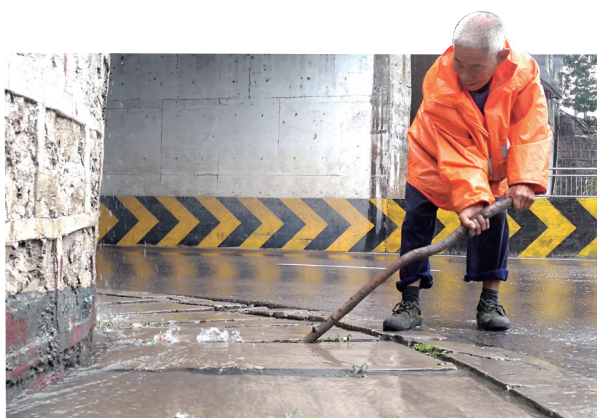
市区凌云路南端铁路立交桥下,环卫工郭付堆在疏通下水道。 本报记者 李英平 摄
