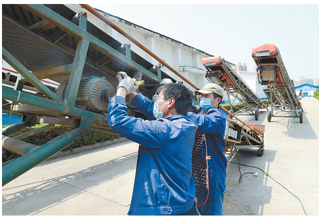
在湛南粮库外,工作人员正在检修输送机,为夏收做准备。
