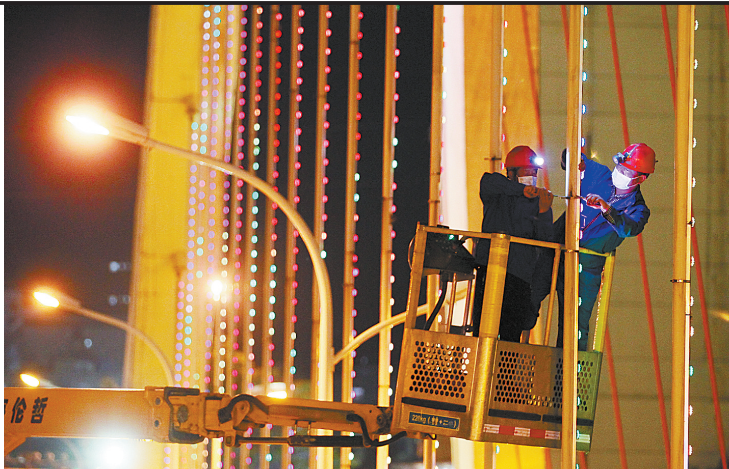
维修人员站在高空作业车上对诚朴路湛河桥上的装饰灯带进行维修
