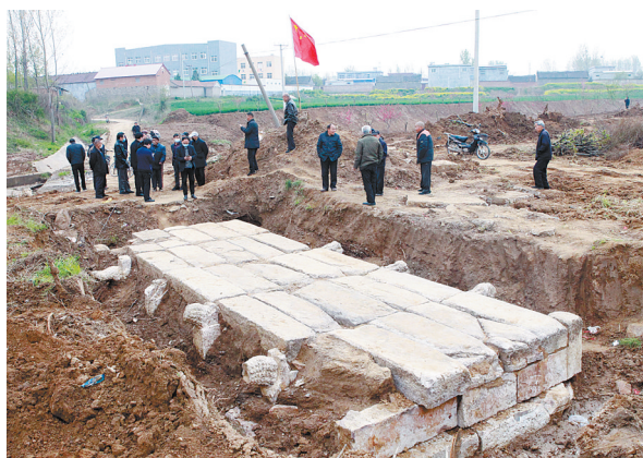
这几天,位于鲁山县张官营镇肖营村北侧的古石桥出土现场,成了附近人气最旺的地方。
