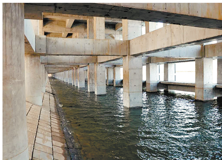
立在水中的码头装卸平台的桩基
