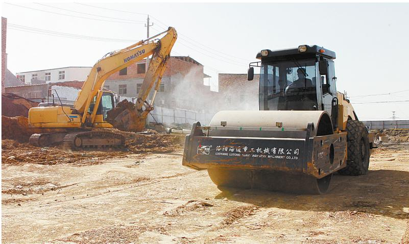
3月24日,在东环路南延施工工地,压路机在进行路基平整碾压
