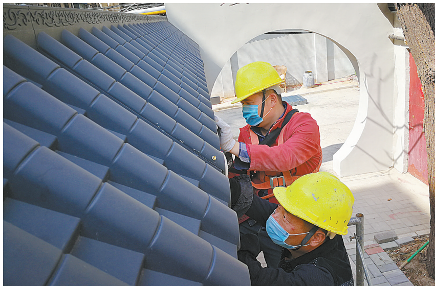
昨天上午,卫东区东安路街道东苑社区建东小区61号楼东侧,施工人员正在为车棚顶安装造型美观的滴水瓦。本报记者 禹舸 摄
