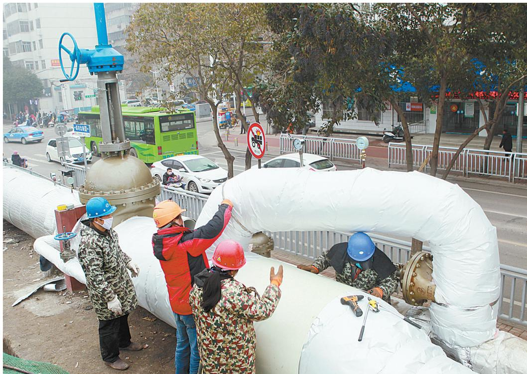
1月11日上午,在市区湛北路上的新建蒸汽管网与原有蒸汽管网连接处,施工人员在为热源东输运行管道进行外层保温防护。 本报记者 李英平 摄
