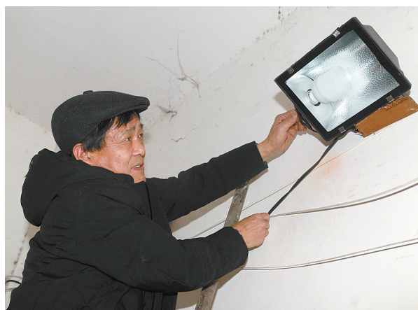
1月6日,张建勇在小区的通道里安装照明灯。
