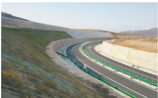
周南高速舞钢段施工区域大部分位于丘陵浅山,施工难度较大。杨德坤摄
