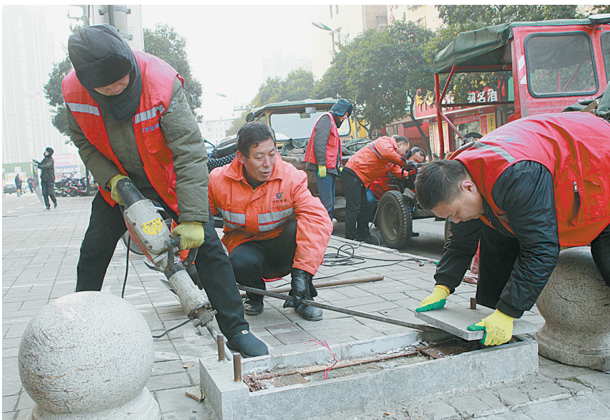
昨天,市区建设路与体育路交叉口北侧,市城管局维修队职工在拆除人行道上废弃的户外广告牌底座。 本报记者 李英平 摄
