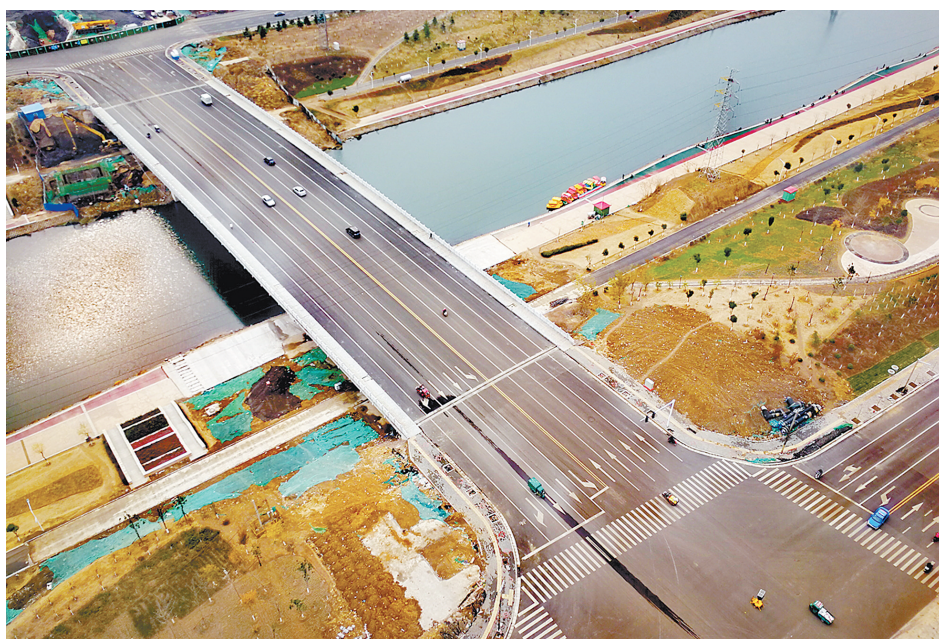
东环路南延湛河桥双向八车道是湛河上最宽的桥梁
