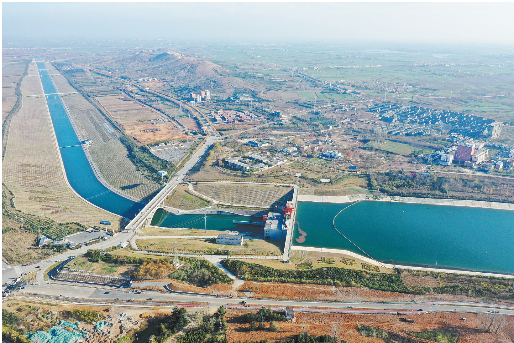
“飞阅”南水北调中线工程渠首
