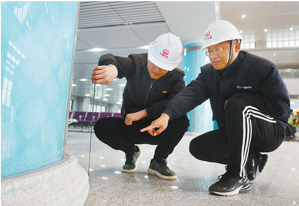
在平西站候车大厅，于福宾（右）和同事正在检测汝瓷造型立柱的安装情况
